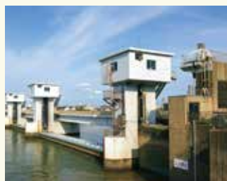
↑新潟大堰(新潟県新潟市)
