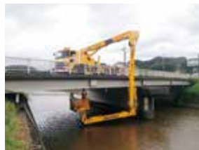
維持管理（橋梁点検）
