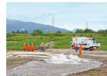
TEC-FORCEによる緊急排水活動訓練
