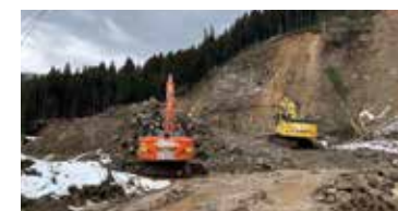
河原田川の迂回水路設置状況（輪島市熊野町）
