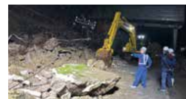
県道1号での啓開作業（輪島市三井町）
