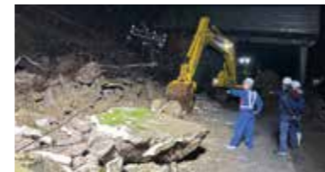
県道1号での啓開作業(輪島市三井町)
