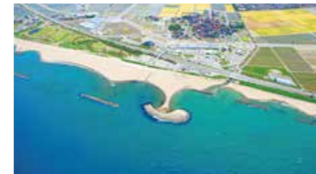
石川海岸(松任工区) 砂浜保全により海岸侵食や高波等の被害を防止し、背後地の住民や財産を守る海岸事業(石川県白山市)
