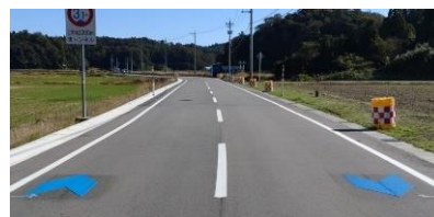
(矢羽根型路面表示設置状況)
