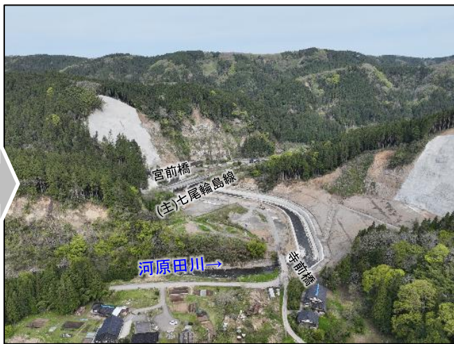
復旧状況 (令和8年4月撮影)
