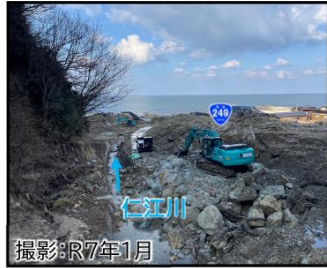
仮設護岸工の施工状況
