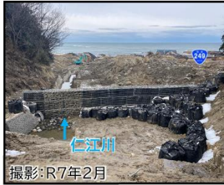
土砂流出防止工の整備状況
