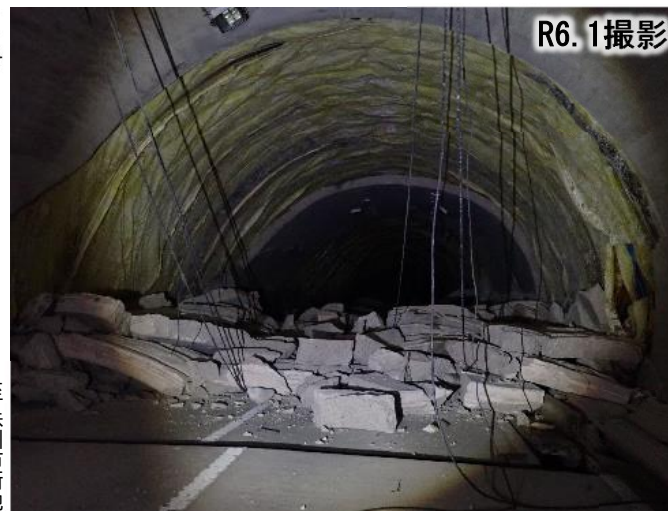
地震によるトンネル覆工崩落
