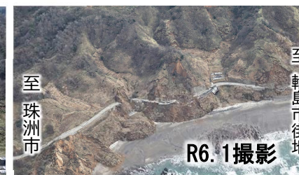
地震による地すべり・斜面崩壊
