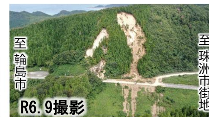
大雨による斜面崩落
