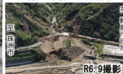
大雨による地すべり
