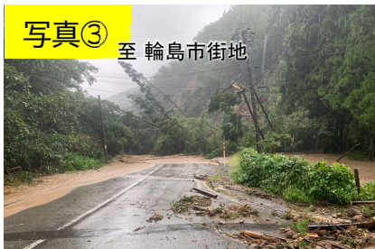
輪島市街地方面を望む (R6.9.21_10時撮影)
