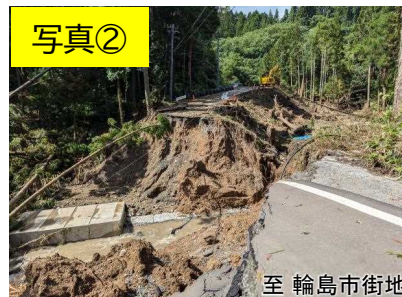
門前地区方面を望む (R6.9.23_14時撮影)
