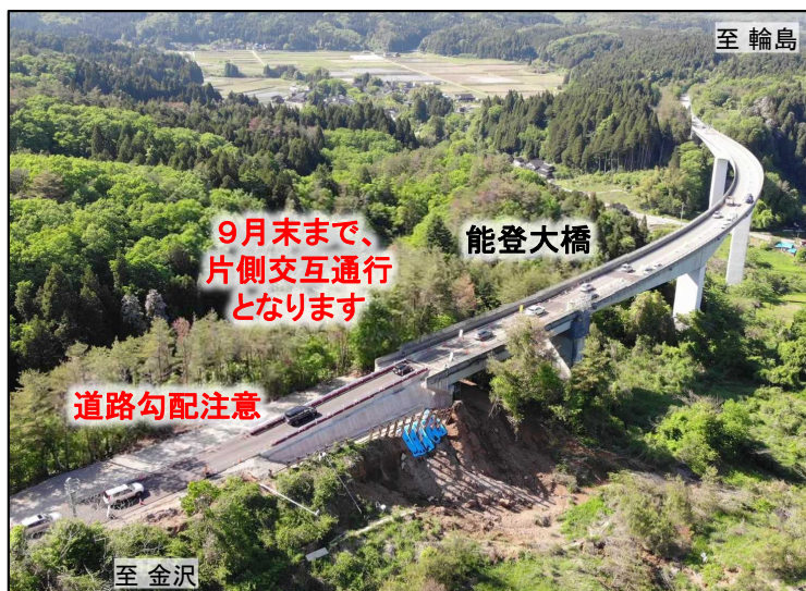
あなみず こし はら のとおおはし 穴水IC～越の原IC 間（能登大橋付近）
