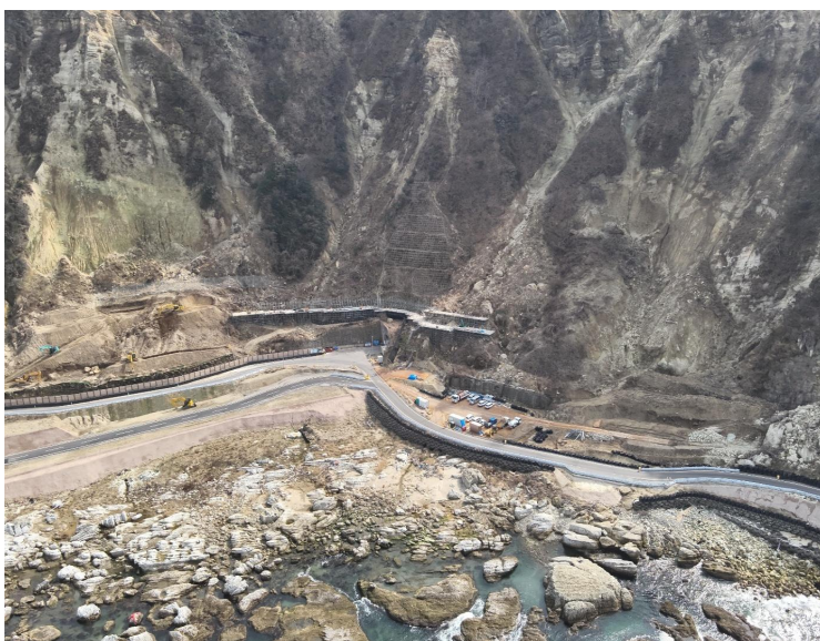
< 2-10 進捗状況写真 >
