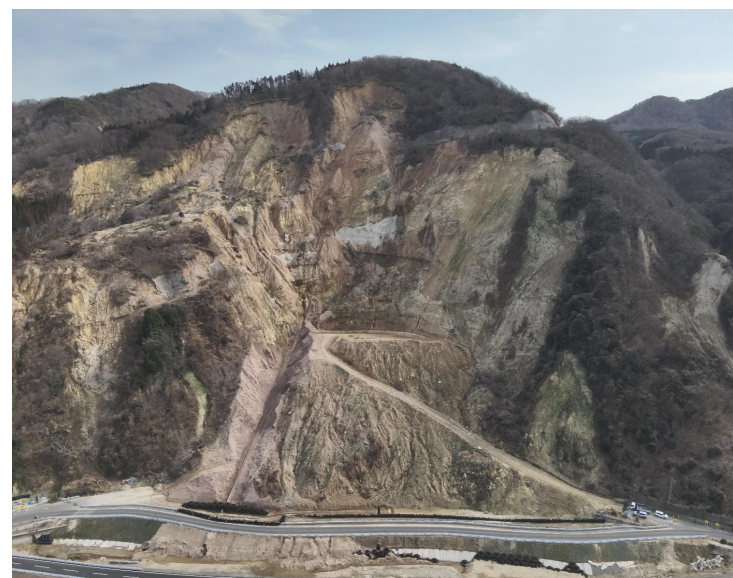
< 2-7 進捗状況写真 >
