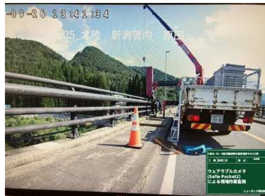
現場事務所より現場状況確認
