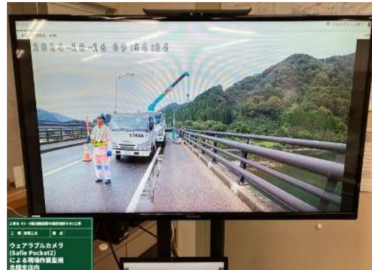
支店より現場状況確認
