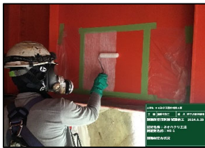
〔剥離剤塗布状況〕
