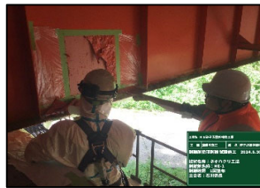
〔塗膜剥離1回目〕
