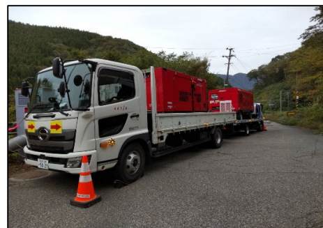
〔発電機・空気圧縮機〕
