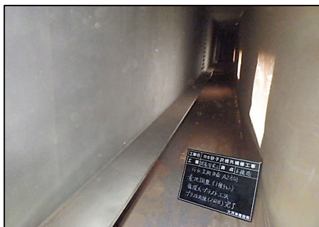
〔素地調整完了 主桁部〕
