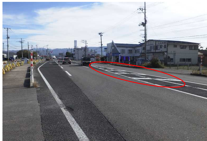
右折車線のすり付け部にゼブラを設置 (R7号 下り線 胎内方面)
