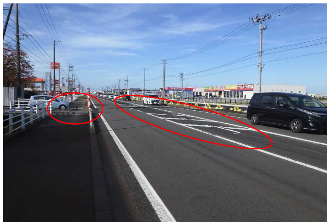
取付道路前後の一部にゼブラを設置 (R7号 上り線 新潟方面)
