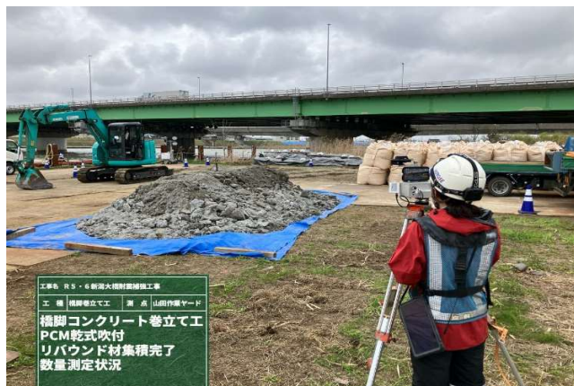
写真.2【新技術】Geo Scanによる3次元測量状況
