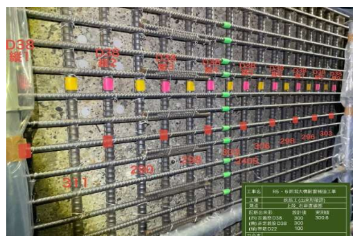
写真.5【新技術】BAIAS (iPad) による出来形写真撮影 →AR表示されたマーカ・数値および電子黒板が反映される
