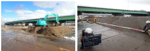
写真.1【従来】重機によるマス立て整形・寸法検測状況
