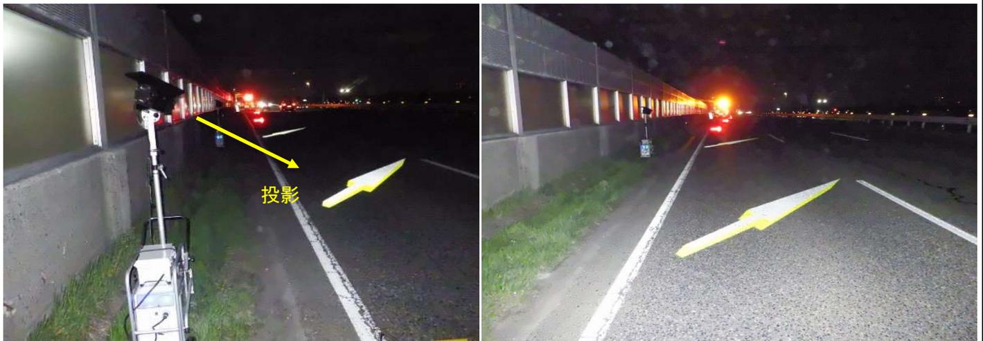
路面に鮮明に標示され、置き型の矢印板に比べ、大きくて目立っているのが確認できる
