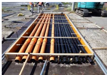
配管完了（打設前）
