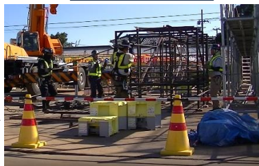
架台組立状況
