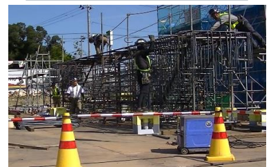
鉄筋組立地上組立状況
