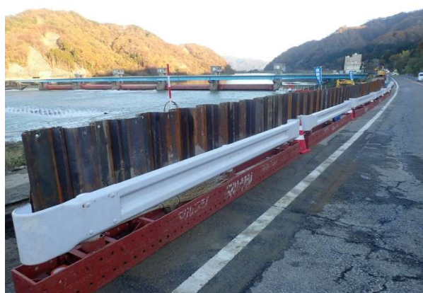
写真5 鋼矢板圧入完了
