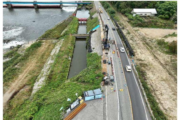
写真1 片側交互通行規制内での作業
