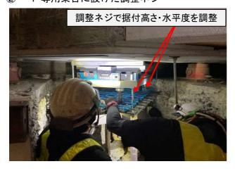
② - 2 空洞を発生させないアングル鋼の専用架台
