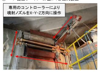
① - 2 機械化施工による規格値内の仕上がり
