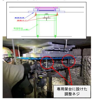
② - 1 専用架台に設けた調整ネジ
