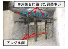
写真 - ② 支承支持材用の専用架台
