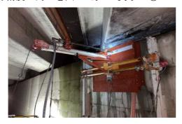
写真 - ① 養生ブース一体型X-Y移動式装置
