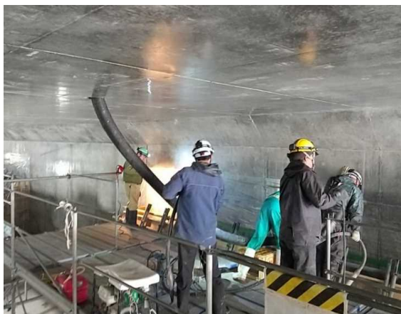
コンクリート打設状況(函渠内)
