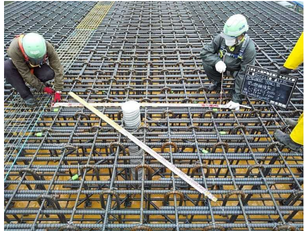
補強鉄筋及びスラブ箱抜き
