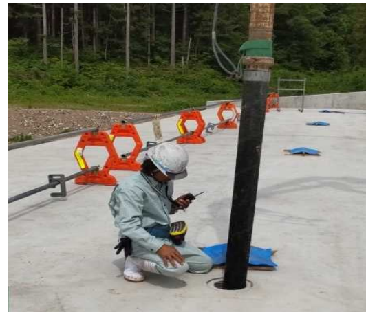
コンクリート打設状況(スラブ上)
