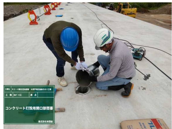
打設用孔閉塞(無収縮モルタル)状況
