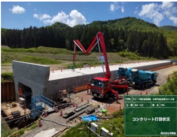
コンクリート打設状況(全景)
