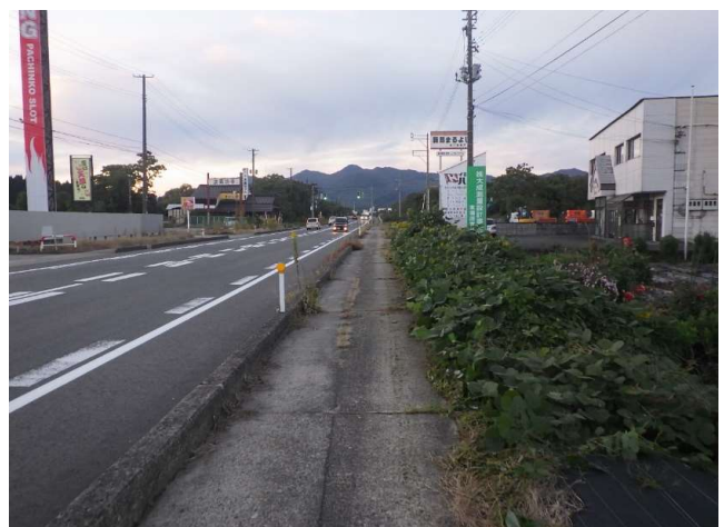
【除草作業 完了】
