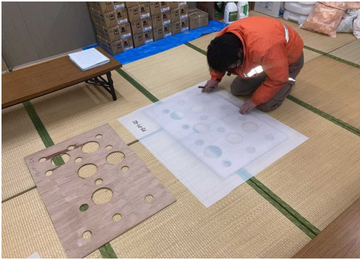
定規を用いたアンカーボルト定着状況
