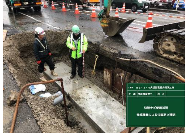
基礎版設置時
