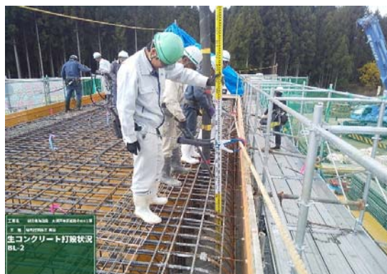
・職員による打設リフト管理@500mm
