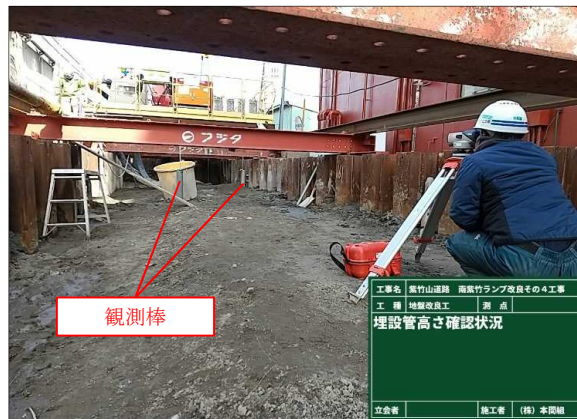
下水道管の変位観測状況
