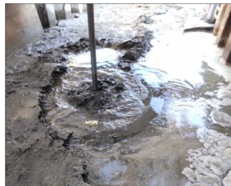
改良状況(施工基面)
