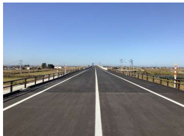
写真-2 ②施工完成
