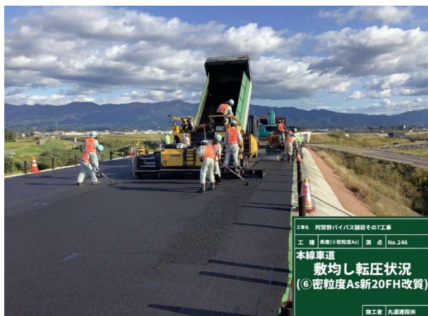
写真-6 ②施工状況
