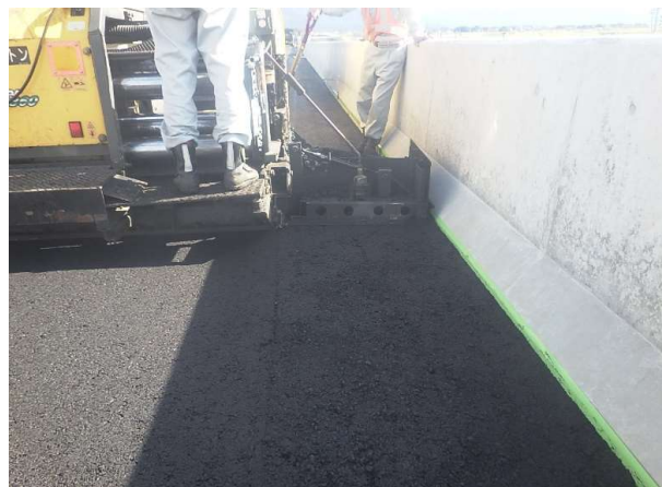
写真-5 アタッチメント設置状況
