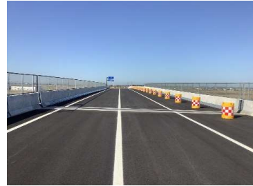
写真-3 ③施工完成
