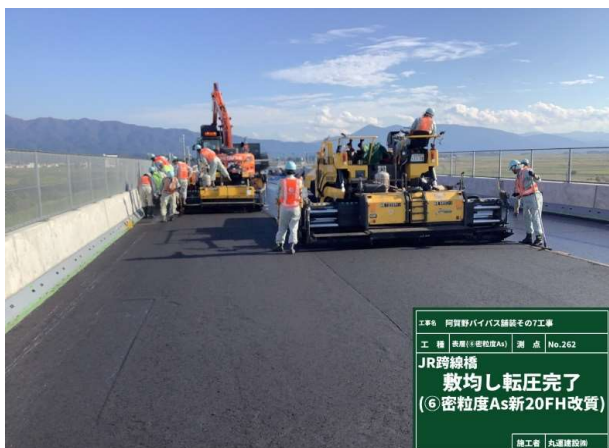
写真-7 ③施工状況
