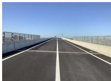
写真-1 ①施工完成
