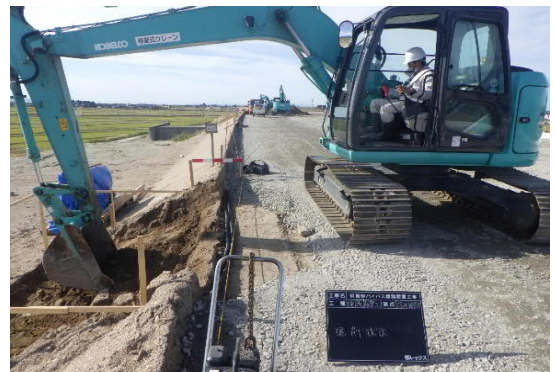
掘削・基礎碎石(1日)
