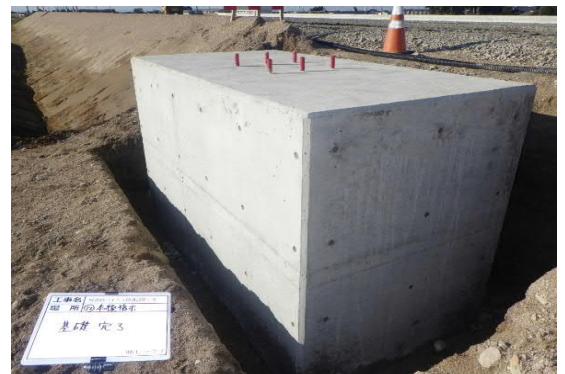
脱型・埋戻し(養生期間3日+1日)
