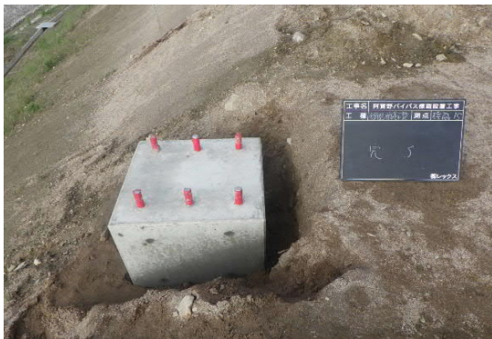
脱型・埋戻し(養生3日間+0.25日)
