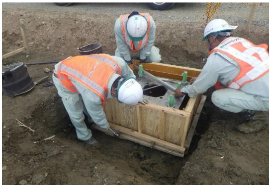
型枠設置・コンクリート打設(0.5日)
