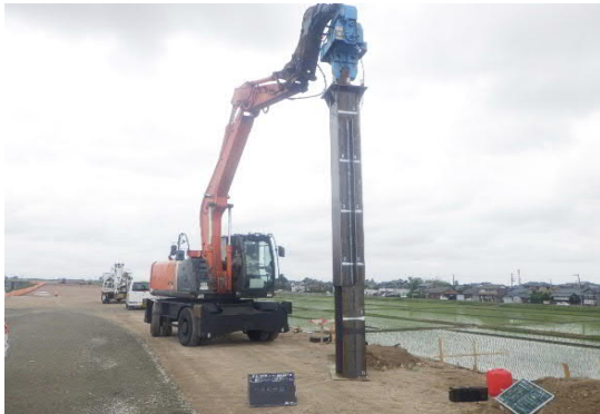
鋼製杭基礎打込(0.25日)
