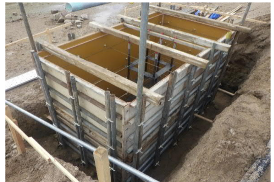
型枠設置・コンクリート打設(2日)
