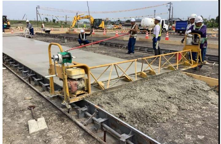
第2回目のレーンでの打設完了時に消雪設備の溝ができる
