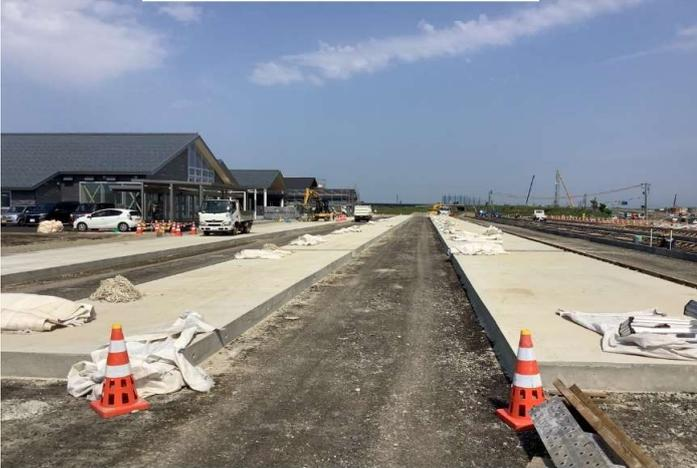
消雪パイプ部分を配管 コンクリート打設
