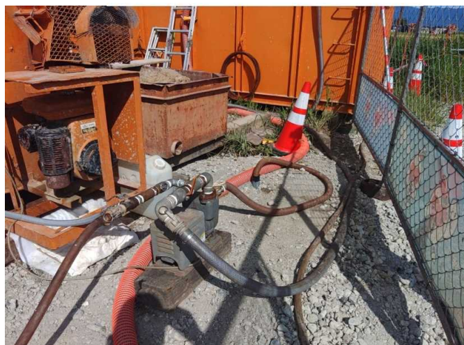
使い水用簡易井戸に水中ポンプ設置
