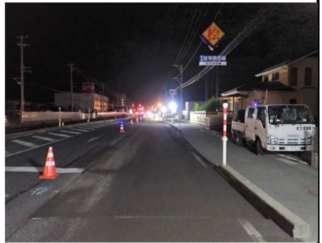
ICT施工 路面切削完了
