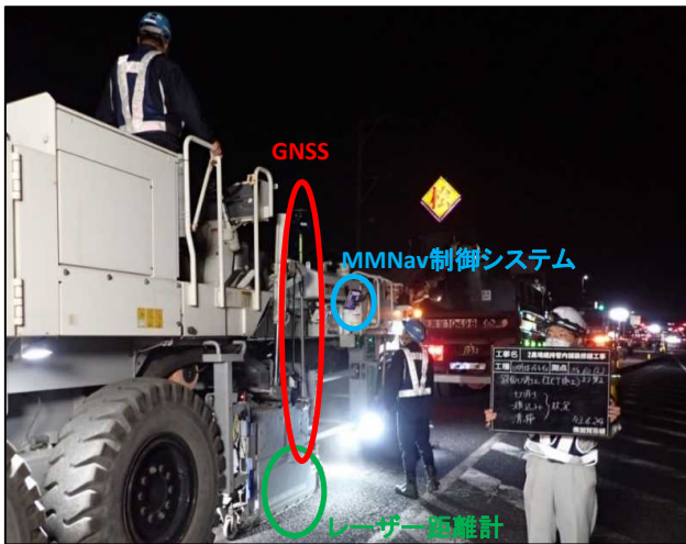
ICT施工 路面切削状況
