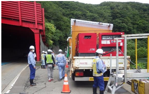
現場据え付け状況
