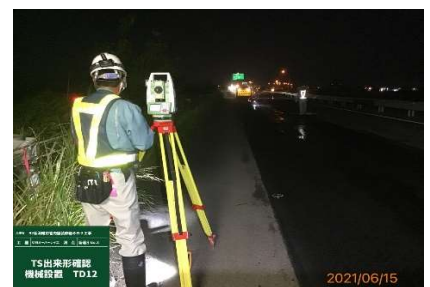
写真-8 TS出来形実施状況
