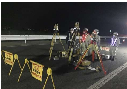
写真-5 TS設置状況
