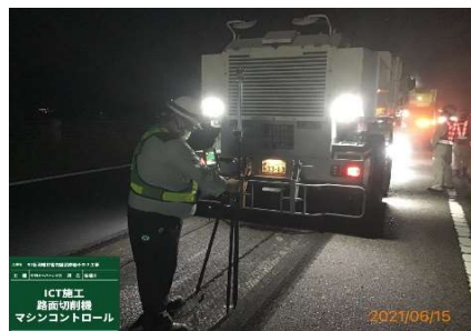
写真-6 切削直後のTS測定状況
