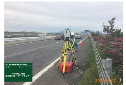
写真-4 3次元起工測量状況
