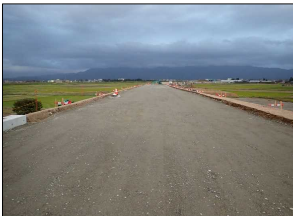
下層路盤完了
