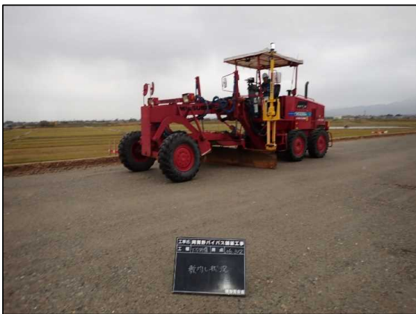
下層路盤の先行施工状況
