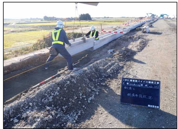
下層路盤完了後、側溝工の施工
