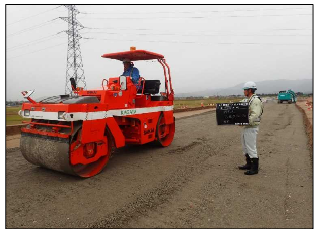
下層路盤の先行施工状況
