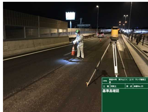
【快測ナビ使用状況写真】
