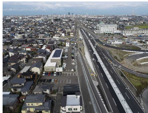
【本線完了時空撮】
