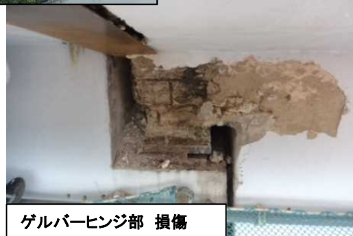
橋脚 断面欠損と鉄筋露出
