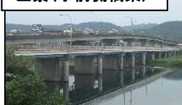
全景(手前側橋梁)
