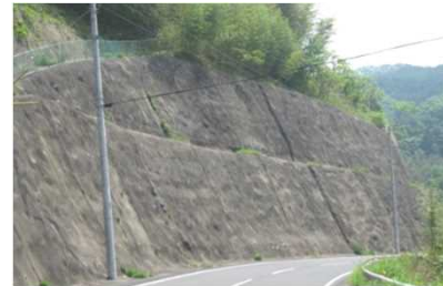
モルタル吹付
