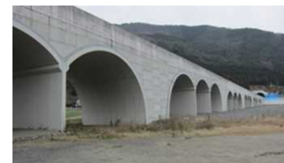
アーチカルバート
