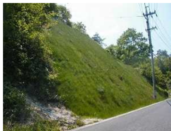
切土(法面保護)
