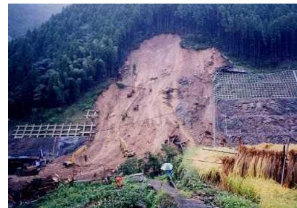
強風化・土砂化斜面での崩壊例
