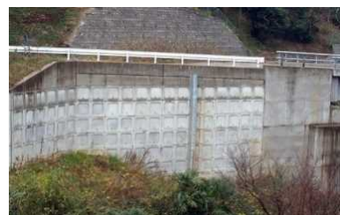
盛土（補強土壁）
