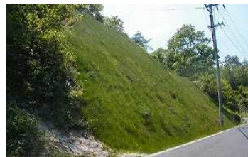
切土（のり面保護）
