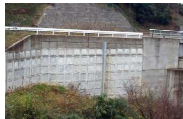
盛土(補強土壁)
