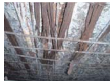
PC鋼材の腐食例
