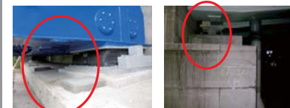
ジャッキアップに配慮した構造
