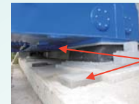
支保交換が容易な構造の例
