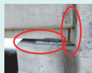
支保交換や桁端点検の空間なし
