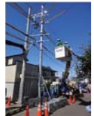
元位置工具新設
