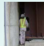
支保交換や桁端点検の空間なし
