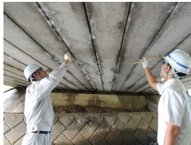
橋梁点検診断研修(9/29 石川県)
