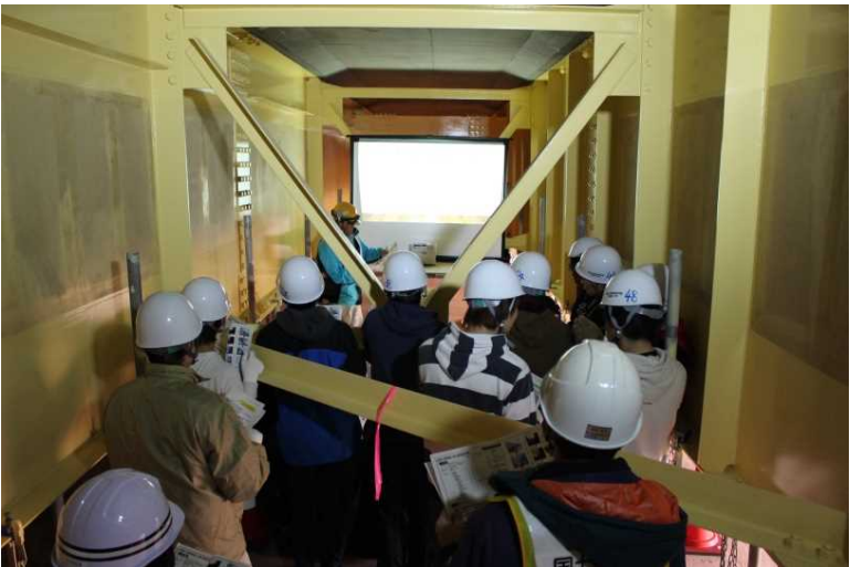
補修工事の見学会(11月10日)
