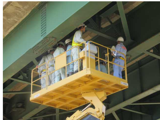
5月20日橋梁初級Ⅰ(西部)点検実習
