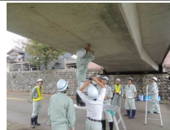
10月1日【石川県】橋梁実地点検実習
