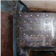
H21修繕後 (主桁修繕)
