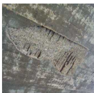
H19損傷状況 (剥離・鉄筋露出)
