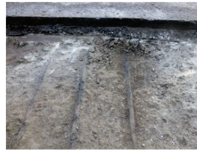
舗装を剥がしての 床版劣化(土砂化)の調査
