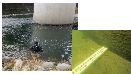
潜水調査による河床洗掘の把握
