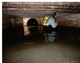
滞水した溝橋内部の目視点検
