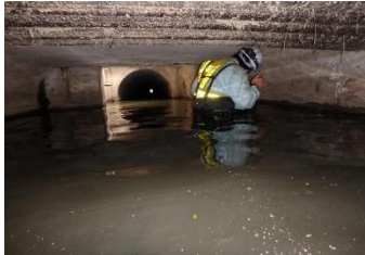
滞水した溝橋内部の目視点検
