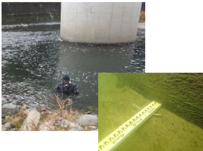
潜水調査による河床洗掘の把握
