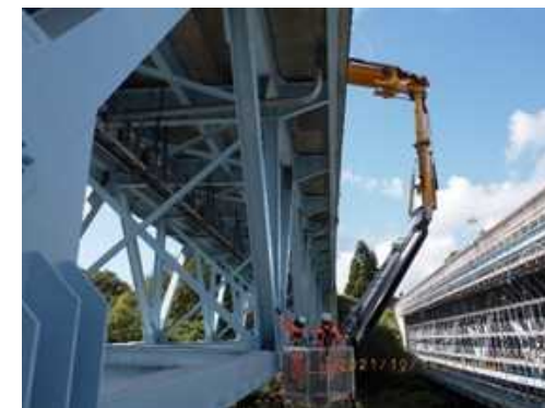
中分側下弦材点検状況
