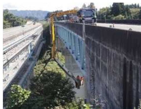
追越車線より差し込み
