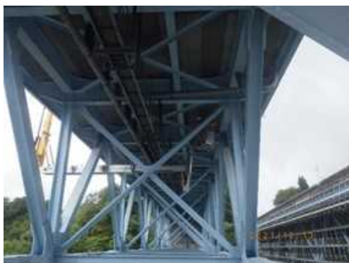
走行車線より差し込み
