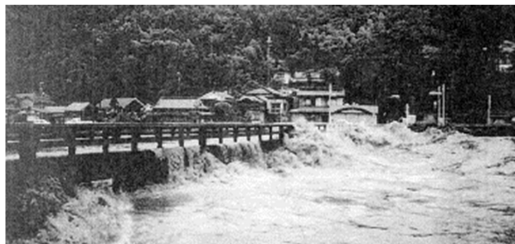
桁下高不足による支障事例
