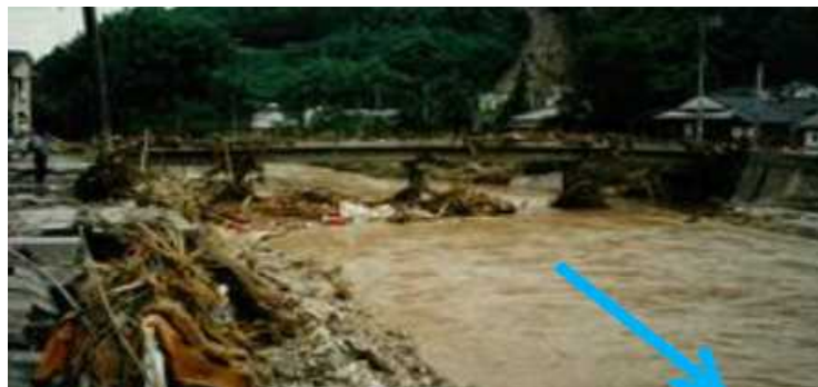
径間長不足、河積阻害による支障事例
