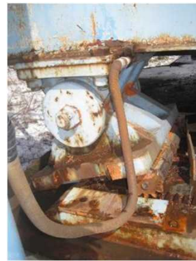
P3支承（可動）： 上部構造の移動に伴いローラーから脱落
