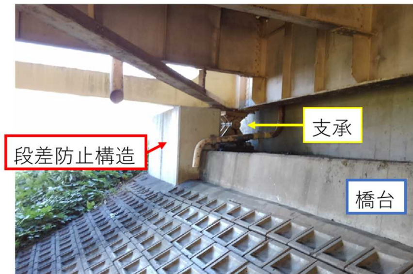
主桁下面の支承前面に設置した例
