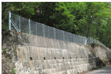
<落石防止柵の取替>
