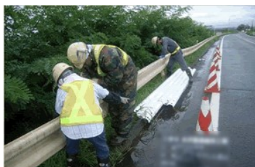
<防護柵の取替>
