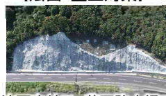
法面吹付工、落石防止網工
