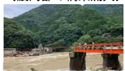
令和2年7月豪雨、熊本県道
