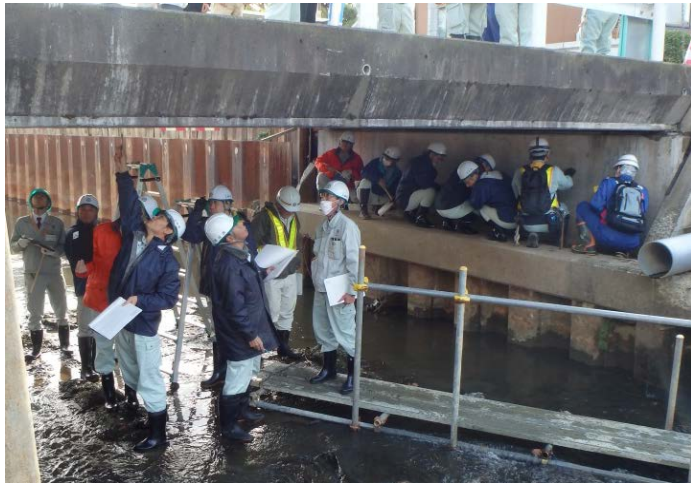
自治体管理橋梁で自治体職員自ら点検 (11月4日 新潟県三条市)
