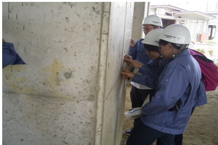
ひび割れ幅を測定している状況
